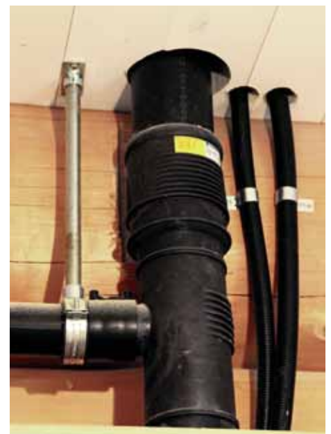
Eine Herausforderung auch für die sanitären Installationen: Schiebemuffen gleichen die Massschwankungen aus.
