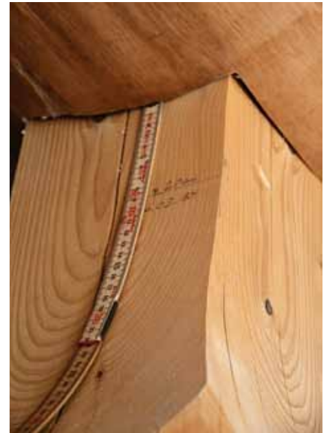
Errechnete 20 cm wird das Blockhaus im Bereich des Türrahmens im Parterreschrumpfen.
