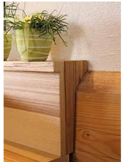
Ausserordentlicher Wandanschluss beim Badmöbel. Die Wand im Hintergrund wird mit der gesamten Gebäudehülle sinken – das Möbel bleibt fest auf dem Boden montiert.
